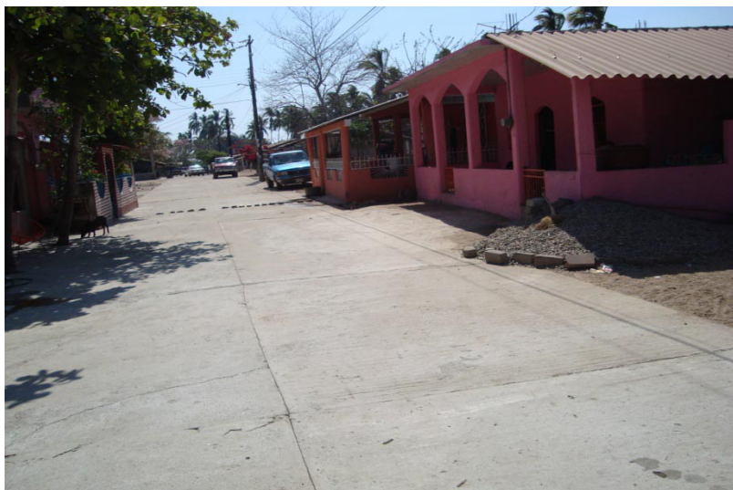
Foto. Pavimentación de calle principal. Tecomate Pesquería, Mpio. San Marcos. Fuente propia (2009)
