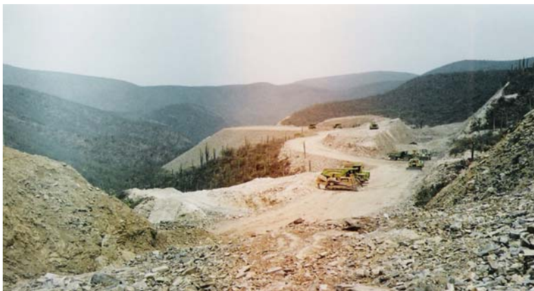
Fotografía 3. Banco de material, Este de Tlaxco
