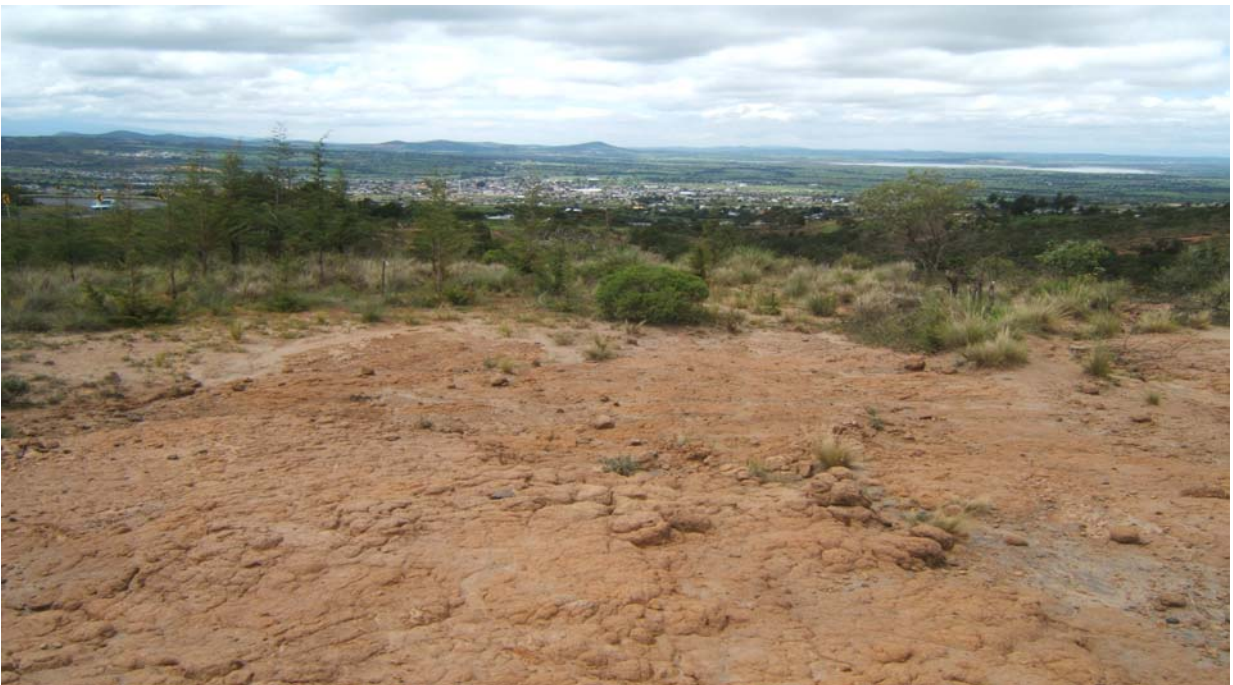
Fotografía 1 Erosión muy alta, al Noreste de Tlaxco
