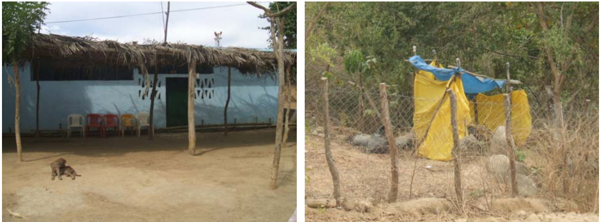
Figura 1.- Vivienda típica en El Espinalillo y sanitarios a cielo abierto
