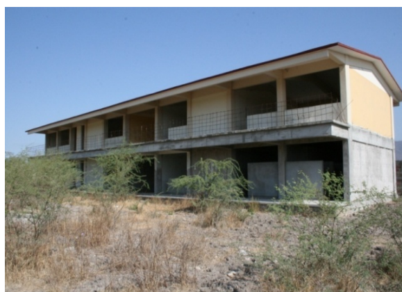
Figura 4: Vista de la construcción de la preparatoria en la localidad de Corral Falso
